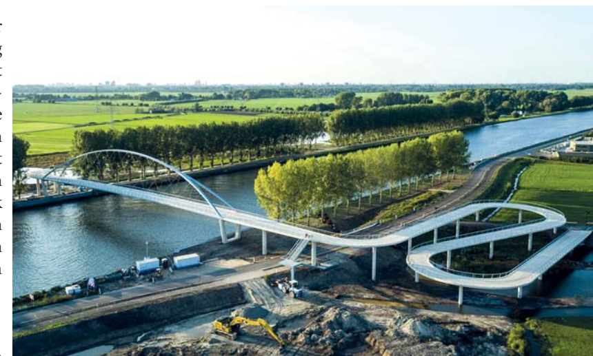
De nieuwe fietsbrug over het Amsterdam-Rijnkanaal is aan beide kanten in de Klein-Muidense klei verankerd. (Foto: IPVDelft)
