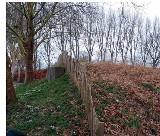
Van de zijkant is goed te zien dat de kruitkelder in een kunstmatige heuvel ligt.
