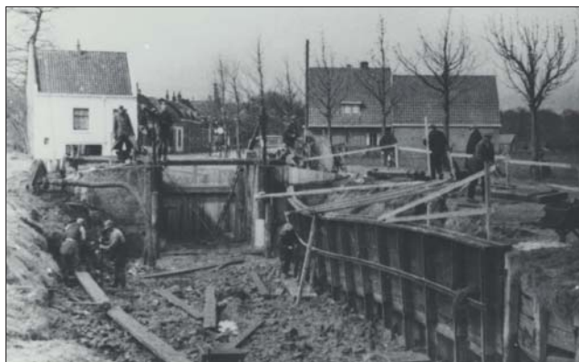
De bouw van een nieuwe schutsluis in de Maarsseveensche Vaart als onderdeel van het inundatiestelsel, 1940. (Collectie Douwe Koen)
