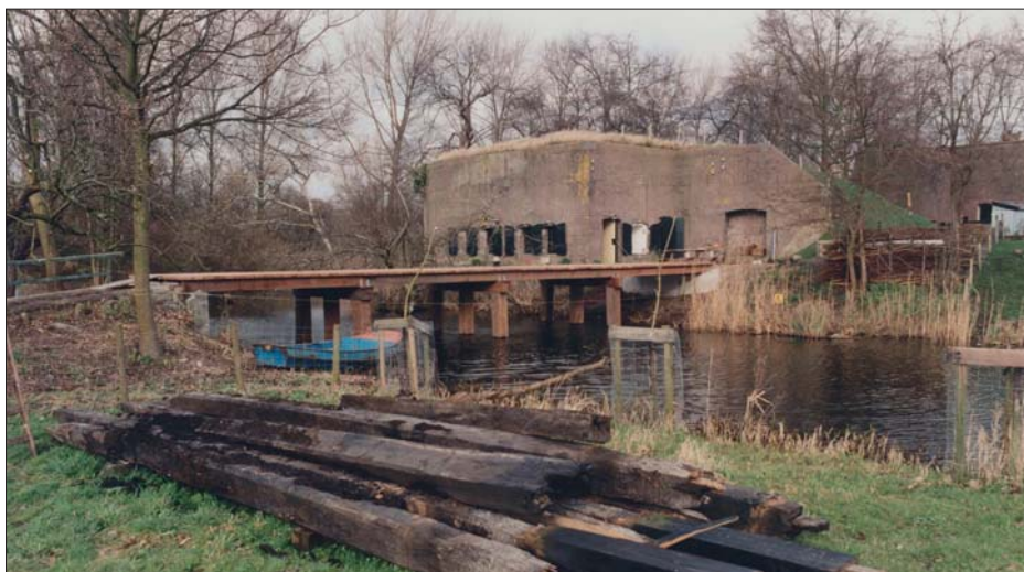
Vernieuwing van de toegangsbrug van Fort Spion ten behoeve van het hergebruik van het fort. (A.R. Visser, 2003)
